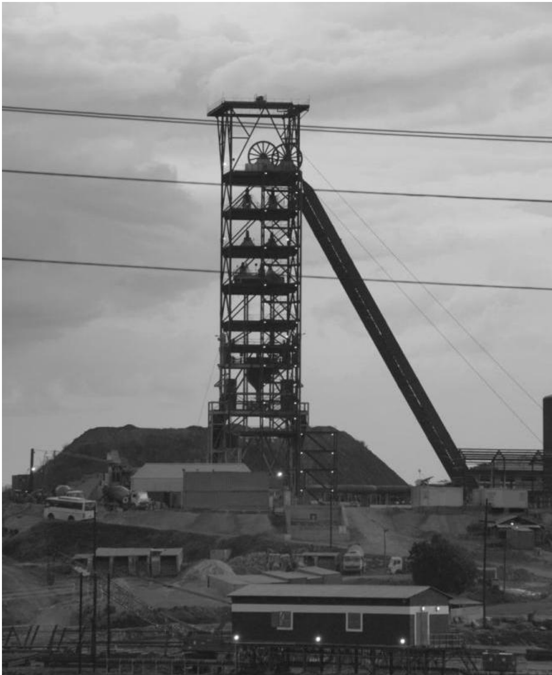
Construction pour la mine souterraine de KibaliGold – Peer Schouten PAX
