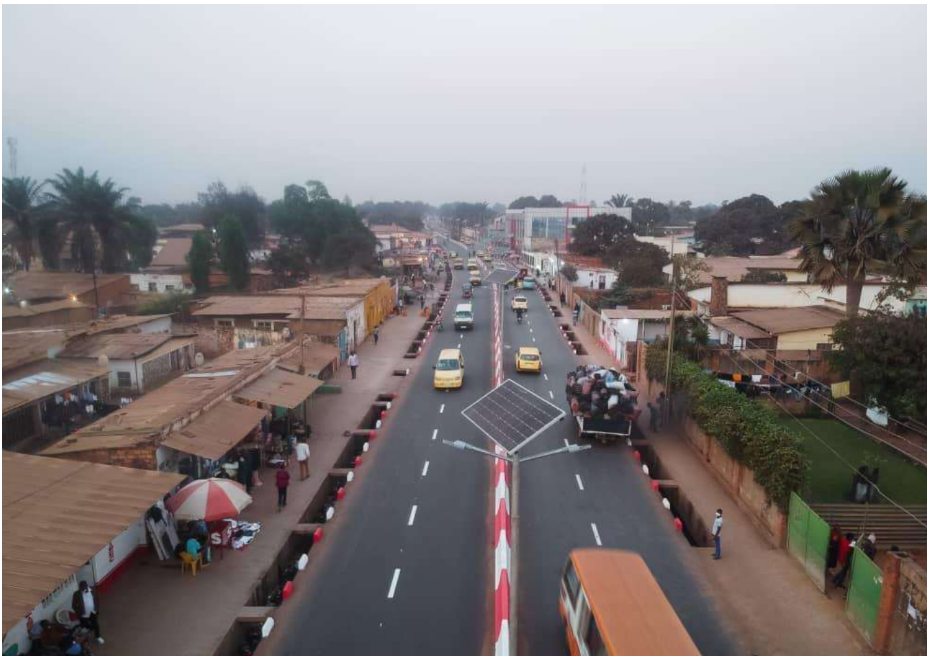
Vue du boulevard Felix Antoine Tshisekedi Ex Chaussée de Kasenga à Lubumbashi renouée par le Gouvernement Provincial
