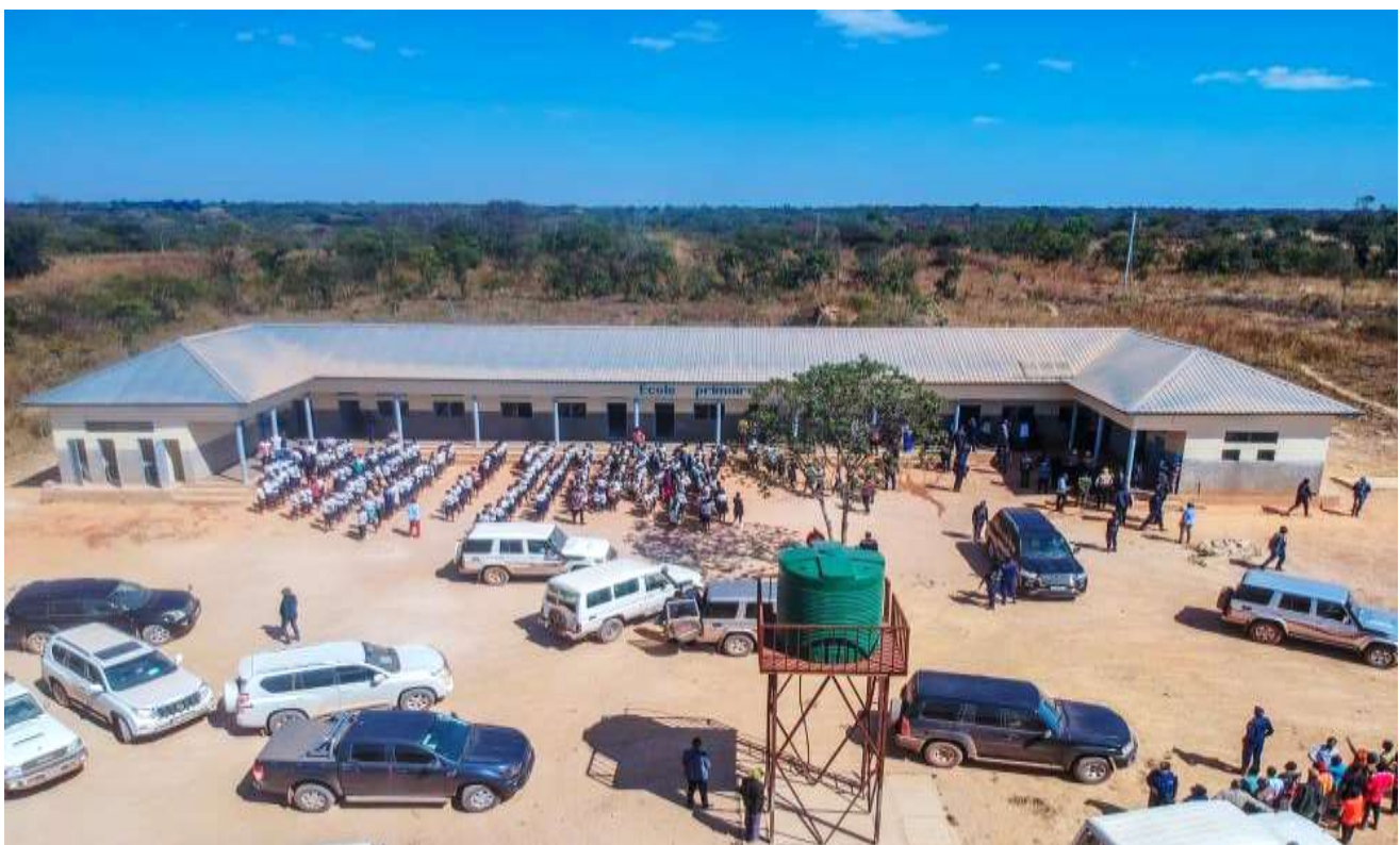
Vue de l'école réhabilitée et puit foré par le SECTEUR BALAMBA grâce à 15% de la redevance minière dans le territoire de SAKANYA.
