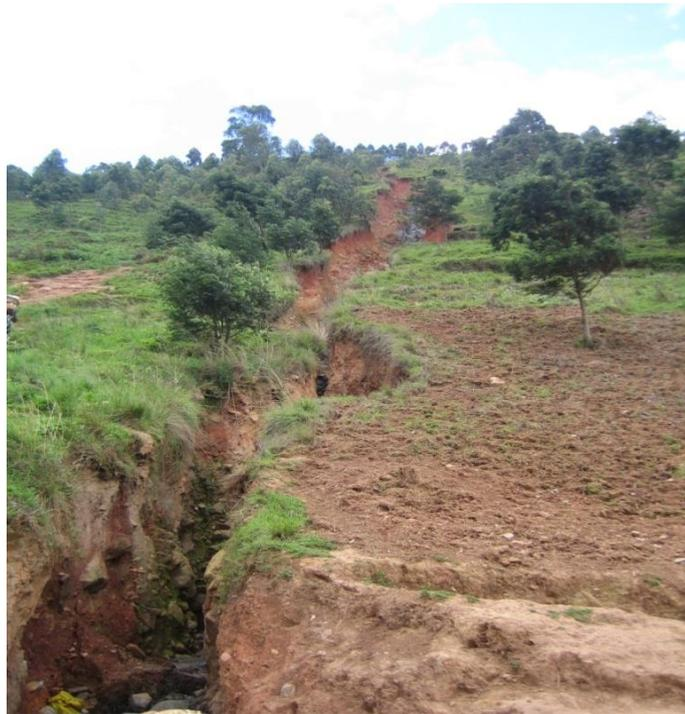
Image 4: Erosion causé par drainage inadéquat de la route
