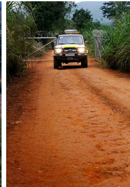
Réhabilitation des routes
